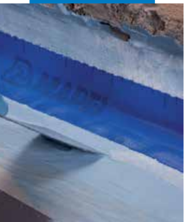
A Mapeband helyére ragasztása Mapelastíc AquaDefense-vel fal és padló vízszintes és függőleges felületei között
