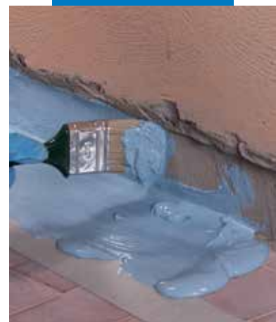
A Mapelastic AquaDefense felhordása ecsettel fal és padló vízszintes és függőleges felületei között a Mapeband helyére ragasztása előtt
