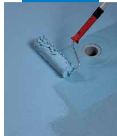
A Mapelastic AquaDefense második rétegének felhordása hengerrel
