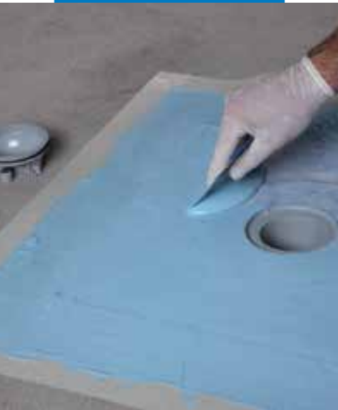
Drain Vertical impregnálása Mapelastíc AquaDefense-vel
